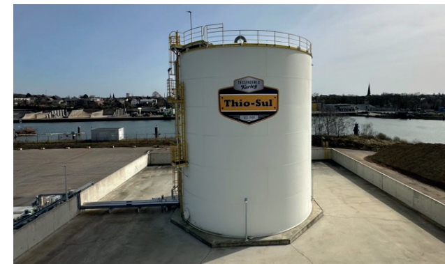
bestickering gevels, silo's en blustanks
